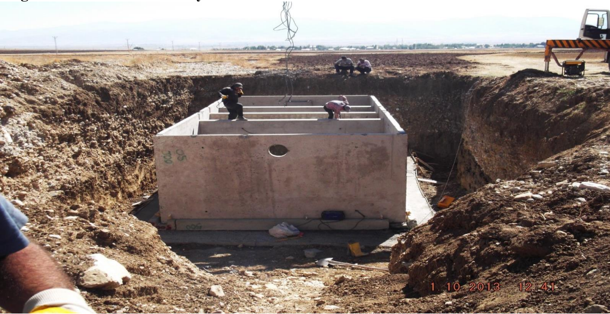
Kağızman bulanık kanalizasyon
