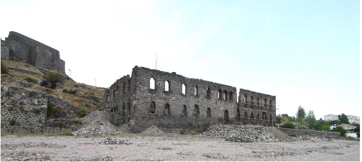
Kars Merkez Beylerbeyi Sarayı Restorasyonu
