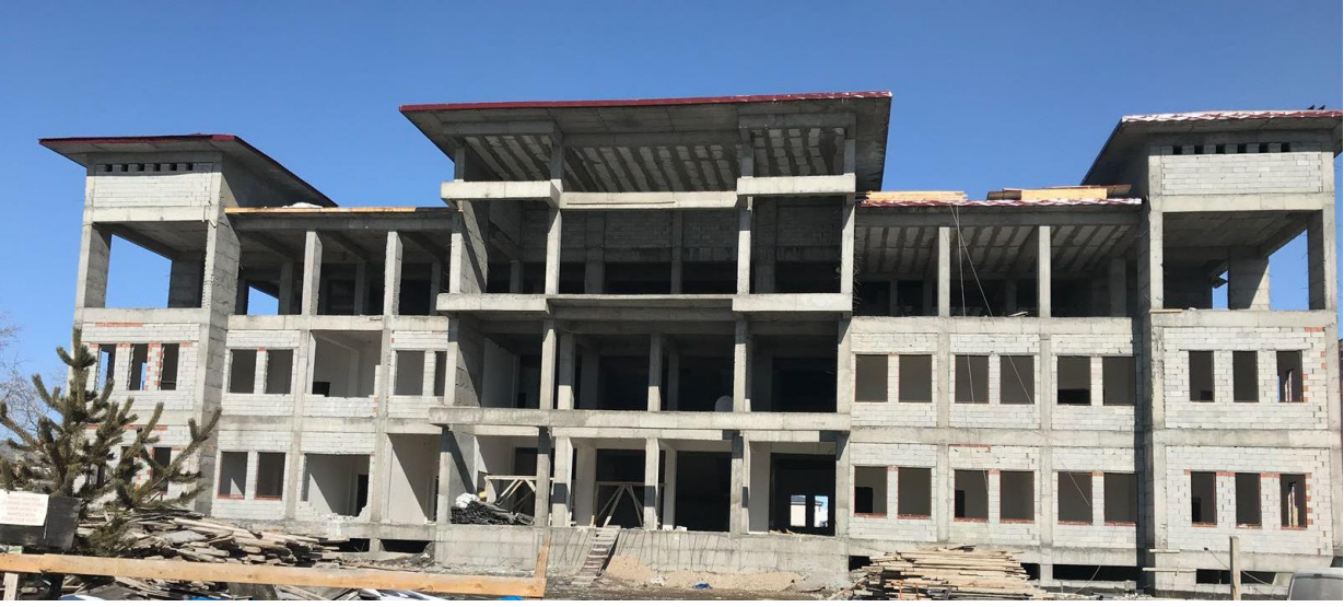
Selim Hükümet Konağı Binası
