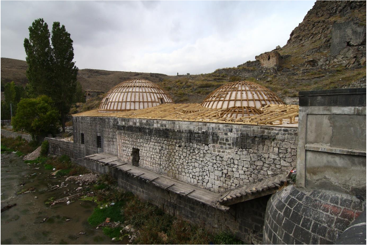
Kars Merkez Muradiye Hamamı Restorasyonu
