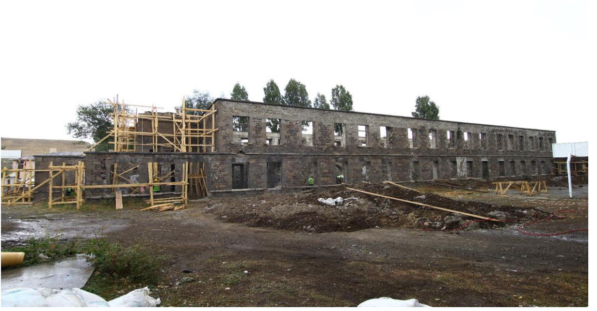
Susuz Hükümet Konağı Restorasyonu
