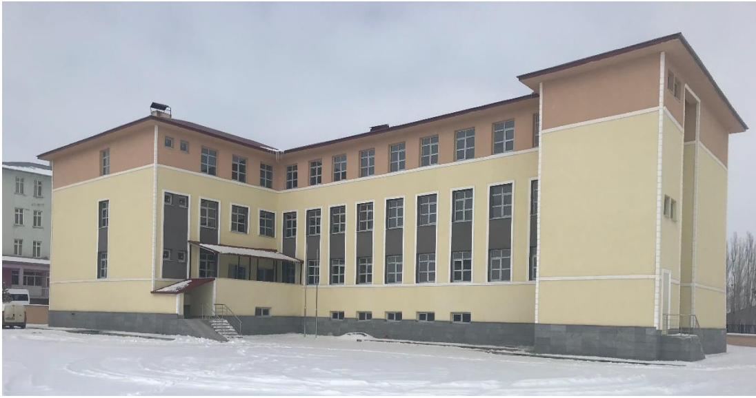
Selim Elektrik Bilişim Atölyesi
