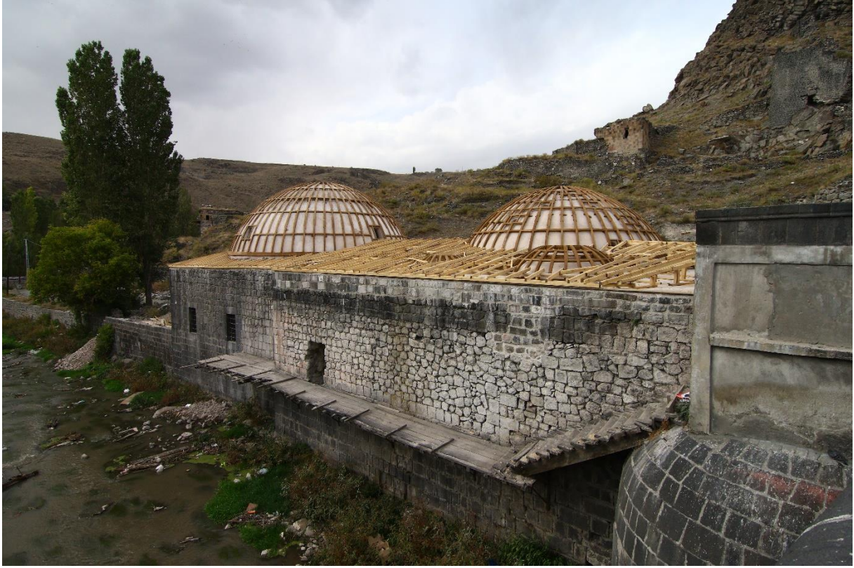
Kars Merkez Muradiye Hamamı Restorasyonu
