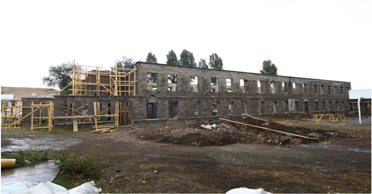
Susuz Hükümet Konağı Restorasyonu
