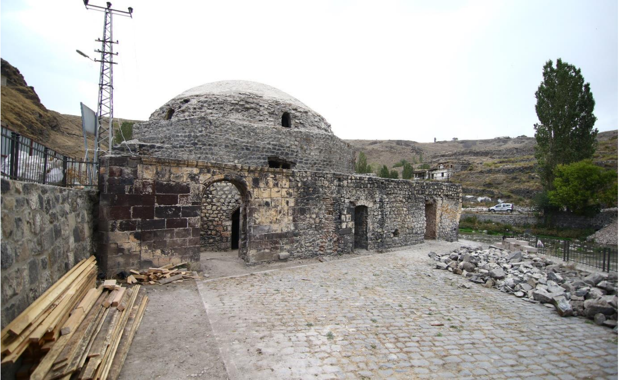
Kars Merkez Mazlum Ağa Hamamı Restorasyonu
