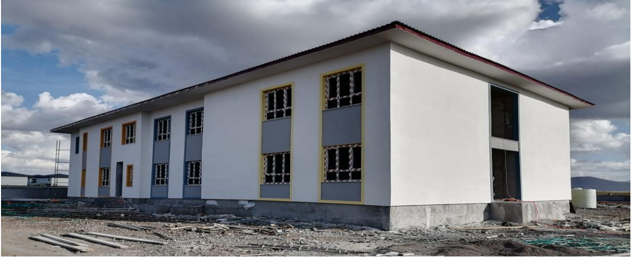
Kars Arpaçay YİBO 16 Derslik Okul İle 200 Kişilik Yurt Yapım İşi
