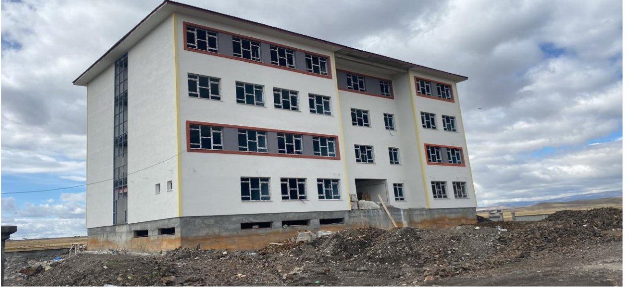
Kars Merkez Karacaören Mah. 12 Derslikli Anaokulu Yapım İşi
