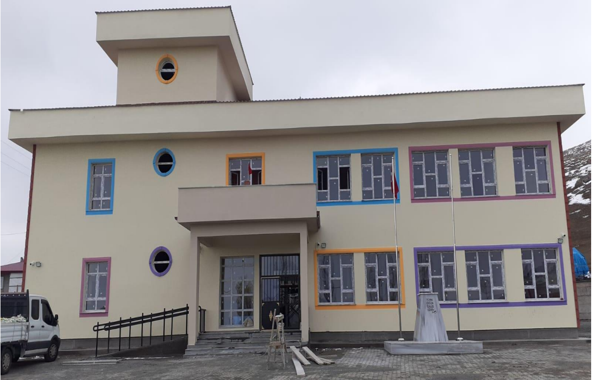
Kağızman Akören Köyü 6 Derslikli Anaokulu Yapım İşi
