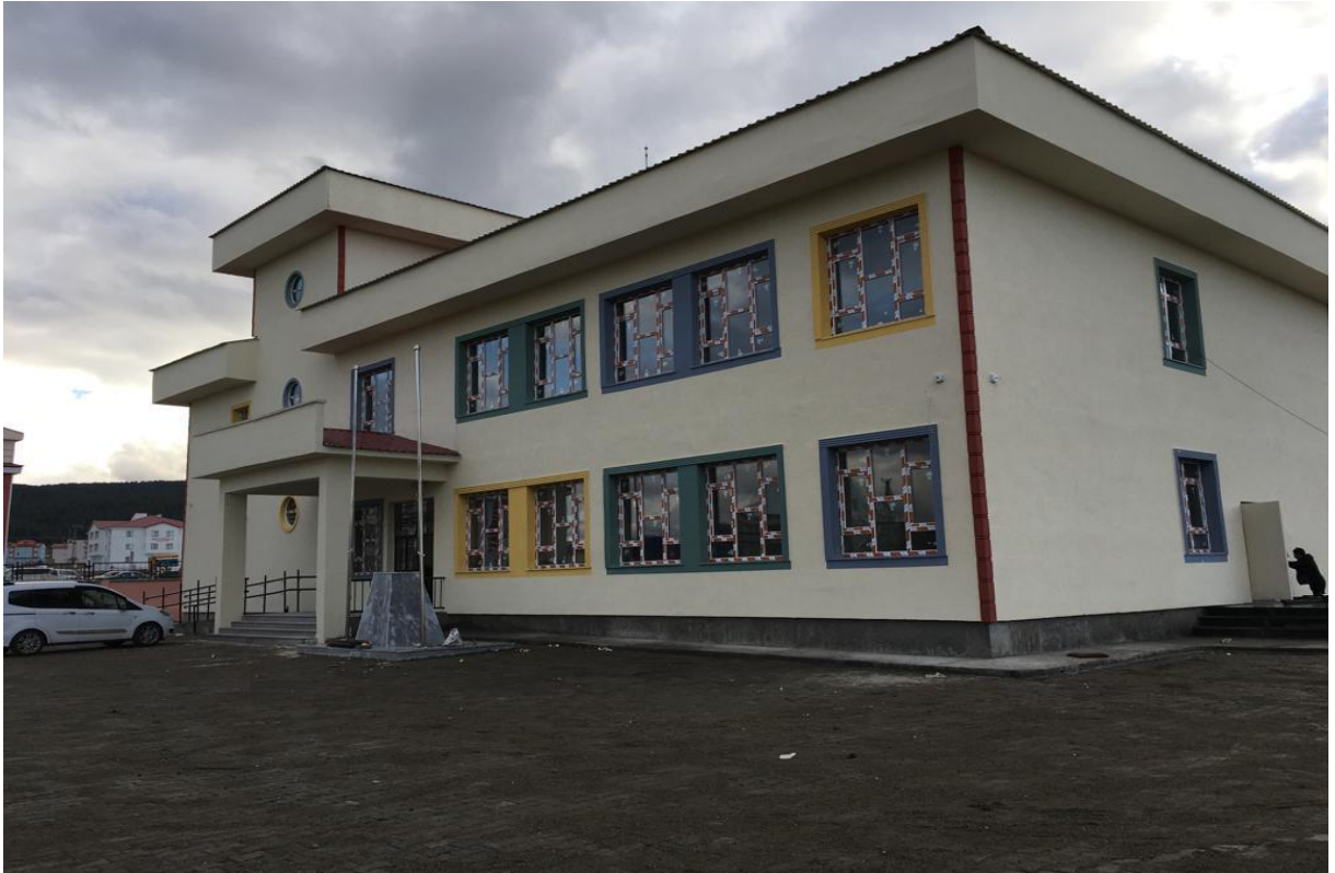
Kars Sarıkamış TOKİ 6 Derslikli Anaokulu Yapım İşi
