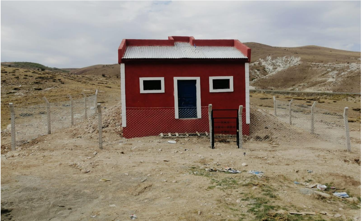
Sarıkamış S ng taşı Depo Onarımı
