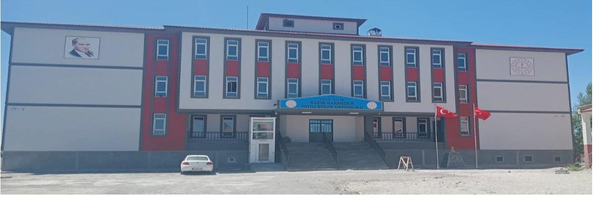
Selim Merkez 8 Derslikli Kazım Karabekir YBO Yapım İşı
