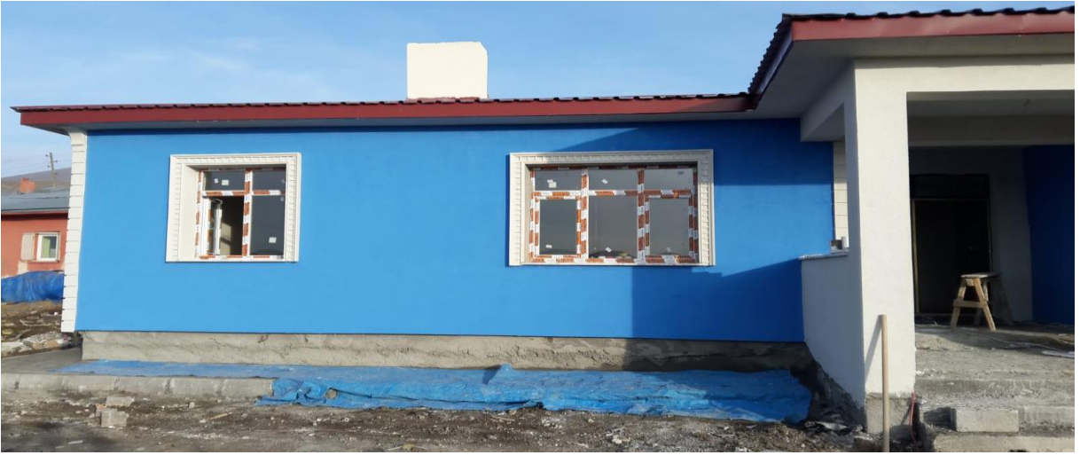
Kağızman Çengilli ve Akyayla Köyleri 4 Daireli Öğretmen Konutu Yapım İşı
