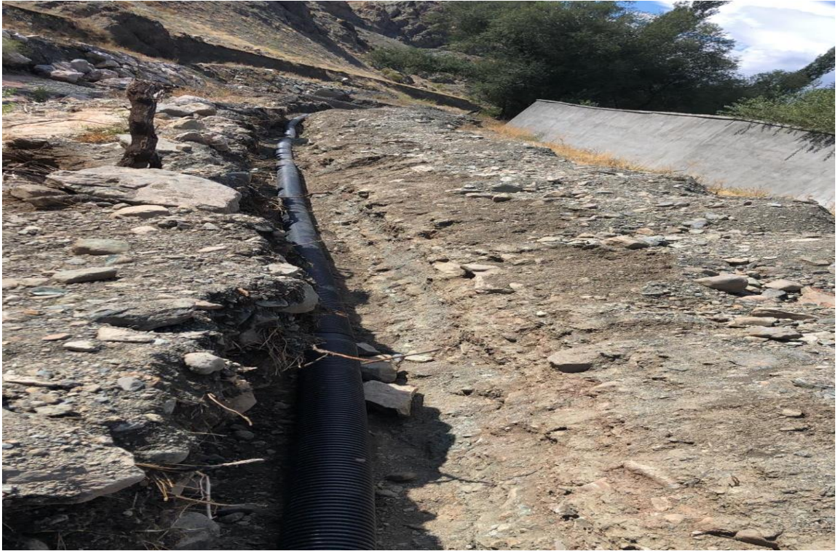
Kağızman Aş.Dut Kanalizasyon Onarımı
