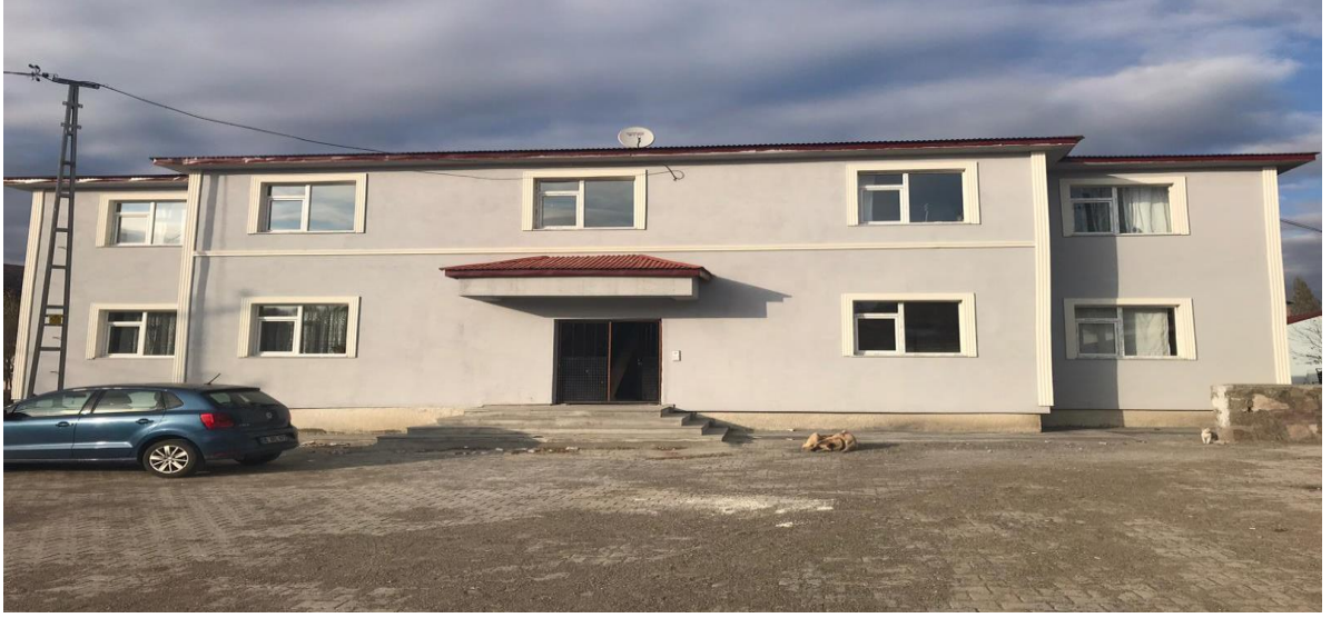
Sarıkamış Eşmeçayır ve Karaorgan Köyleri 4 Daireli Öğretmen Konutu Yapım İşi
