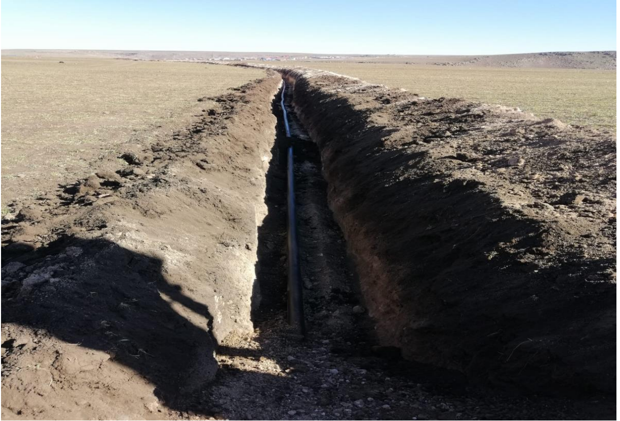
Arpaçay Doğruiyol köyü içmesuyu yapım
