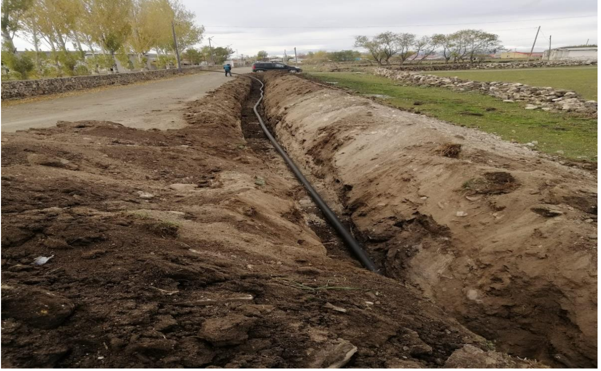
Akyaka Karahan köyü isale hattı yapımı
