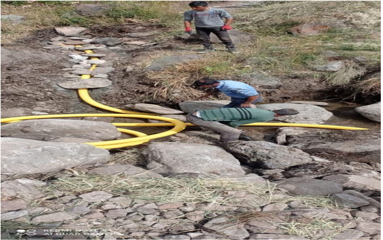
Kağızman Örmeli Drenajla Su Toplama
