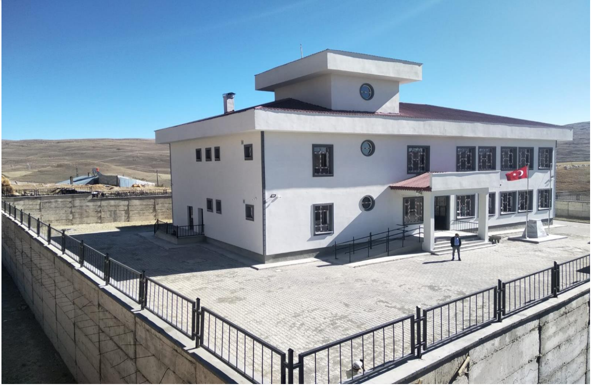
Sarıkamış Çardak çatı Köyü 6 Derslikli Anaokulu Yapım İşi
