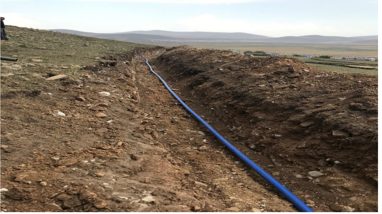
Digor Yağlıca köyü isale hattı yapımı
