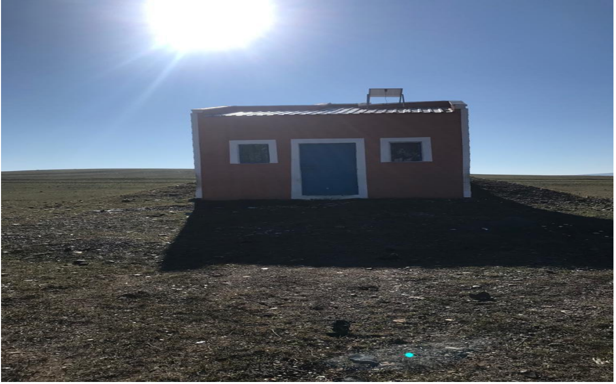
Selim avlak Depo Onarımı
